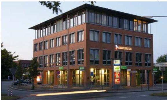
Außenansicht der MA HSH
